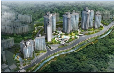
공동주택 해운대 센텀두산위브
