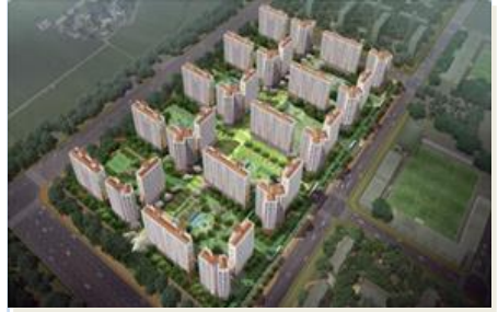
공동주택 명지 협성휴포레
